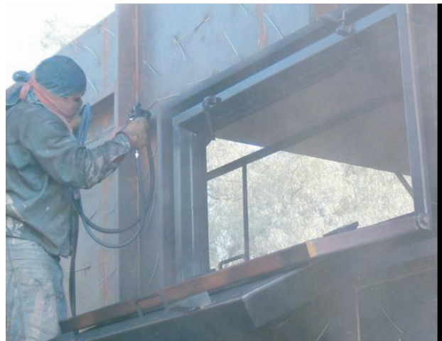
Aplicação por pulverização de CorrosionGard-50S
